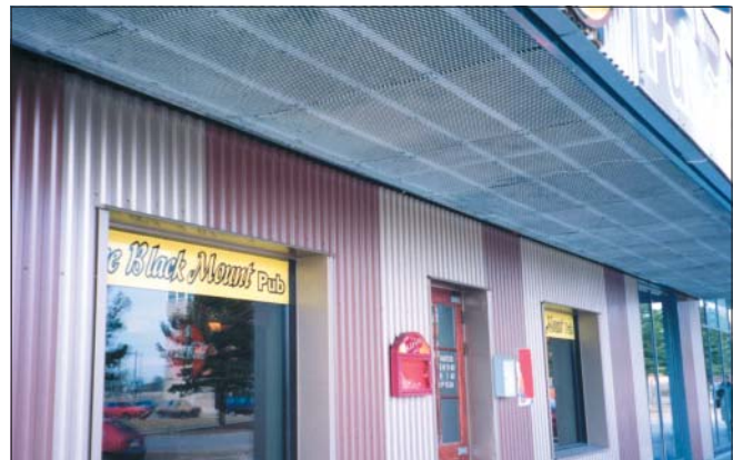
Навес с горячеоцинкованной сеткой P2,5/4 у бара в Таллинне
