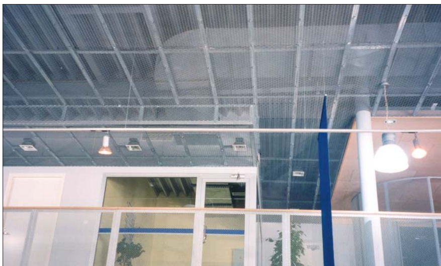
Подвесной потолок в центре PEUGEOT в Таллинне (2003 г.). Большие 1200x2000 мм панели из сетки P2.5/4, порошковая краска
