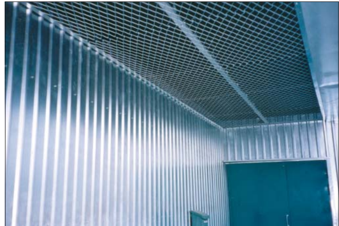
Потолок терминала в Таллинне. Сетка A34, горячий цинк
